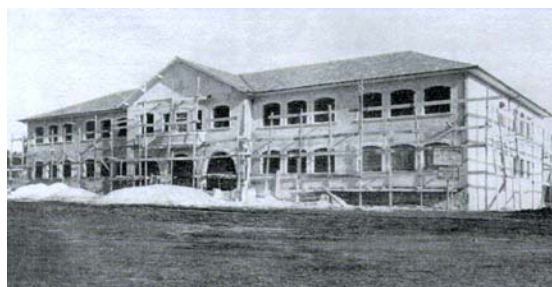
FIGURA 3 - DETALHE DA CONSTRUÇÃO DO GRUPO ESCOLAR CRISTO REI
